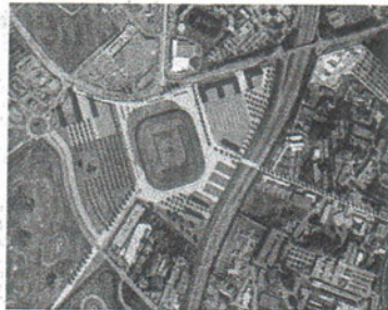
Aménagement possible du site de la Borne de l'Espoir. (Photo : Agence de développement et d'urbanisme Lille métropole).
